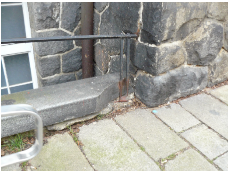
Detail poškození kamenné koruny
